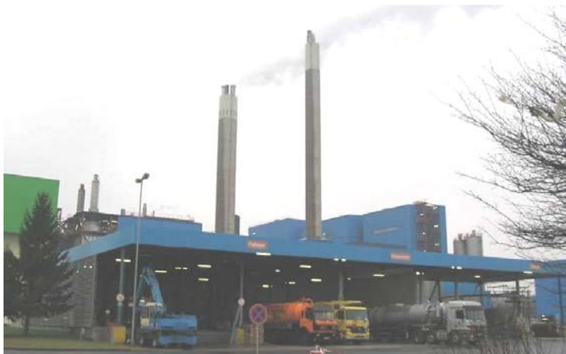
Vedere zona de descărcare a deșeurilor la incinerator
